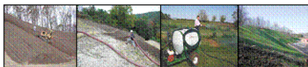
Слика 1. Поступак извођење хидросетве
