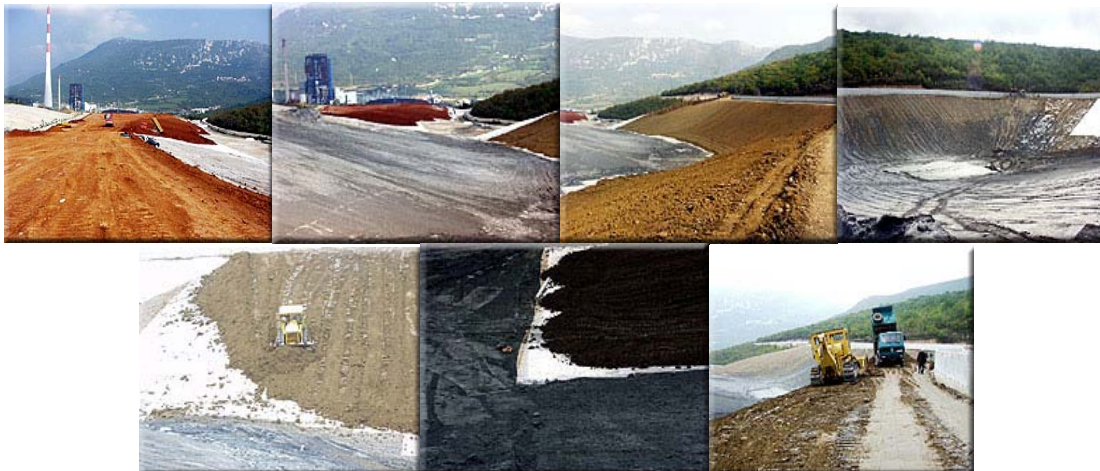
Слика 3. Рад на постављању бентонита приликом рекултивације
